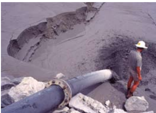
Pembuangan konvensional tailing lumpur
