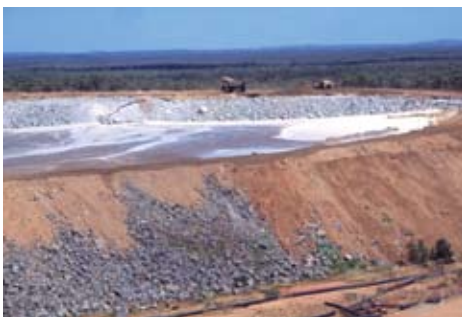
Konstruksi hilir
