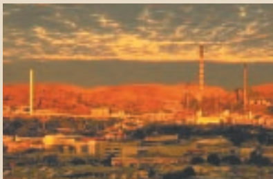
Peleburan tembaga Xstrata di Mount Isa Mines—peleburan tembaga (cerobong merah putih) dan fasilitas pengolah asam (cerobong putih)
