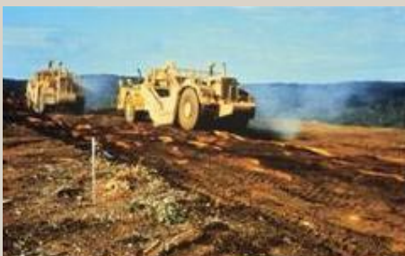
Desbastado del suelo
