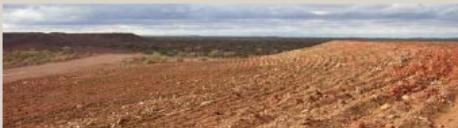
图为穆林穆林镍矿公司凹坡施工完工时的情况
