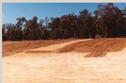
再次铺敷的表层土
